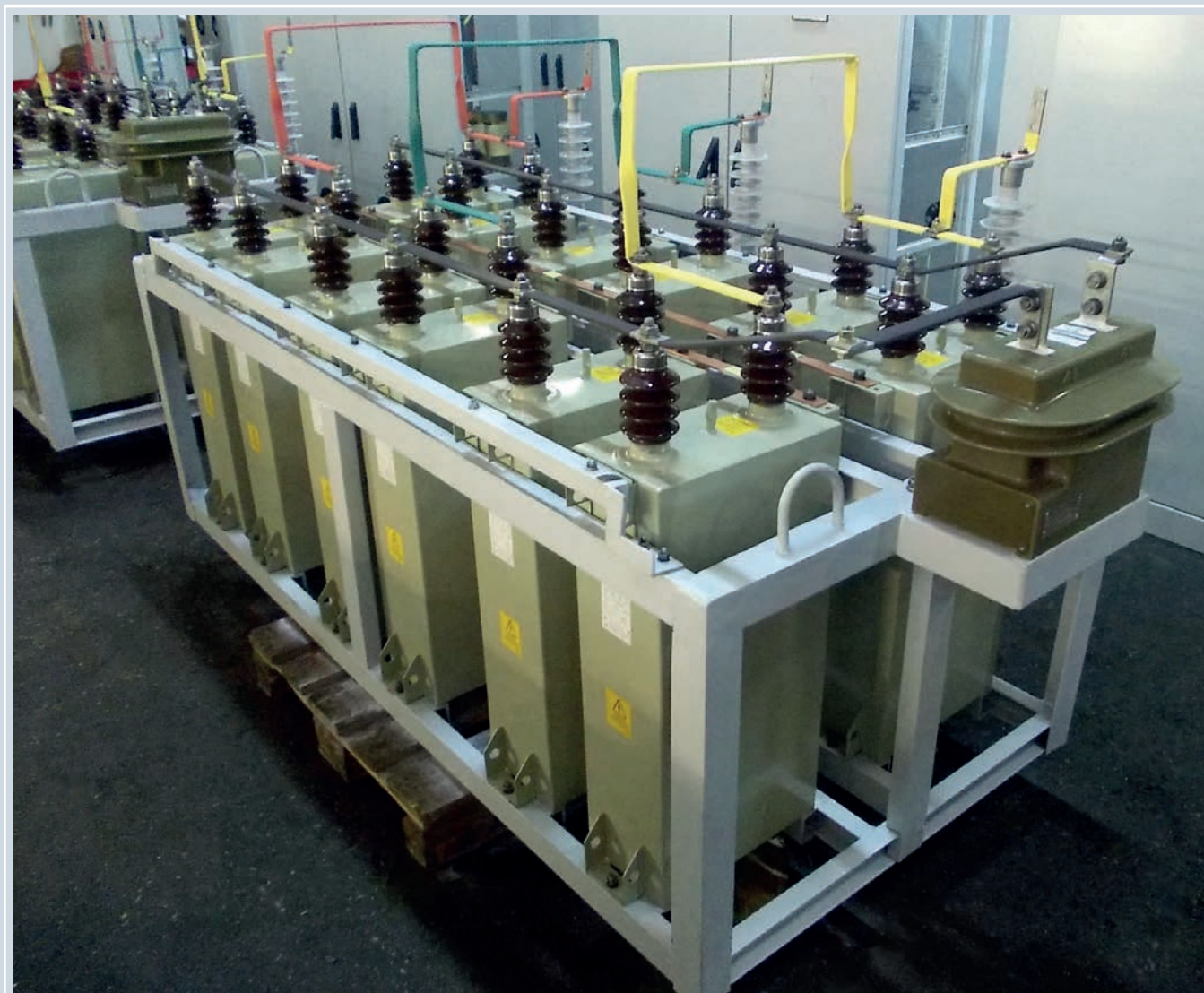
Батарея статических конденсаторов БСК-6,3-4,2 МВАр. В данный момент эксплуатируется на предприятии ОАО «Брянскэнерго», г. Брянск.
