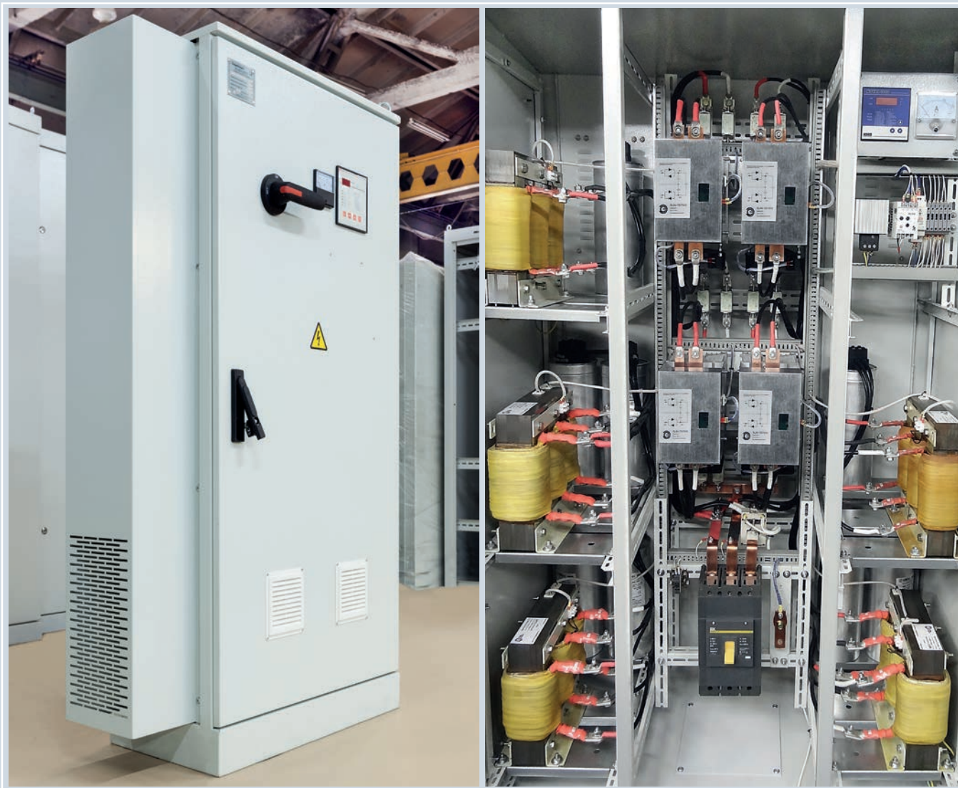
Тиристорная фильтровая конденсаторная установка КРМТ-0,4-325-25 У3 с фильтрами гармоник. В данный момент эксплуатируется на предприятии ОАО «Золотые луга», г. Тюмень.
