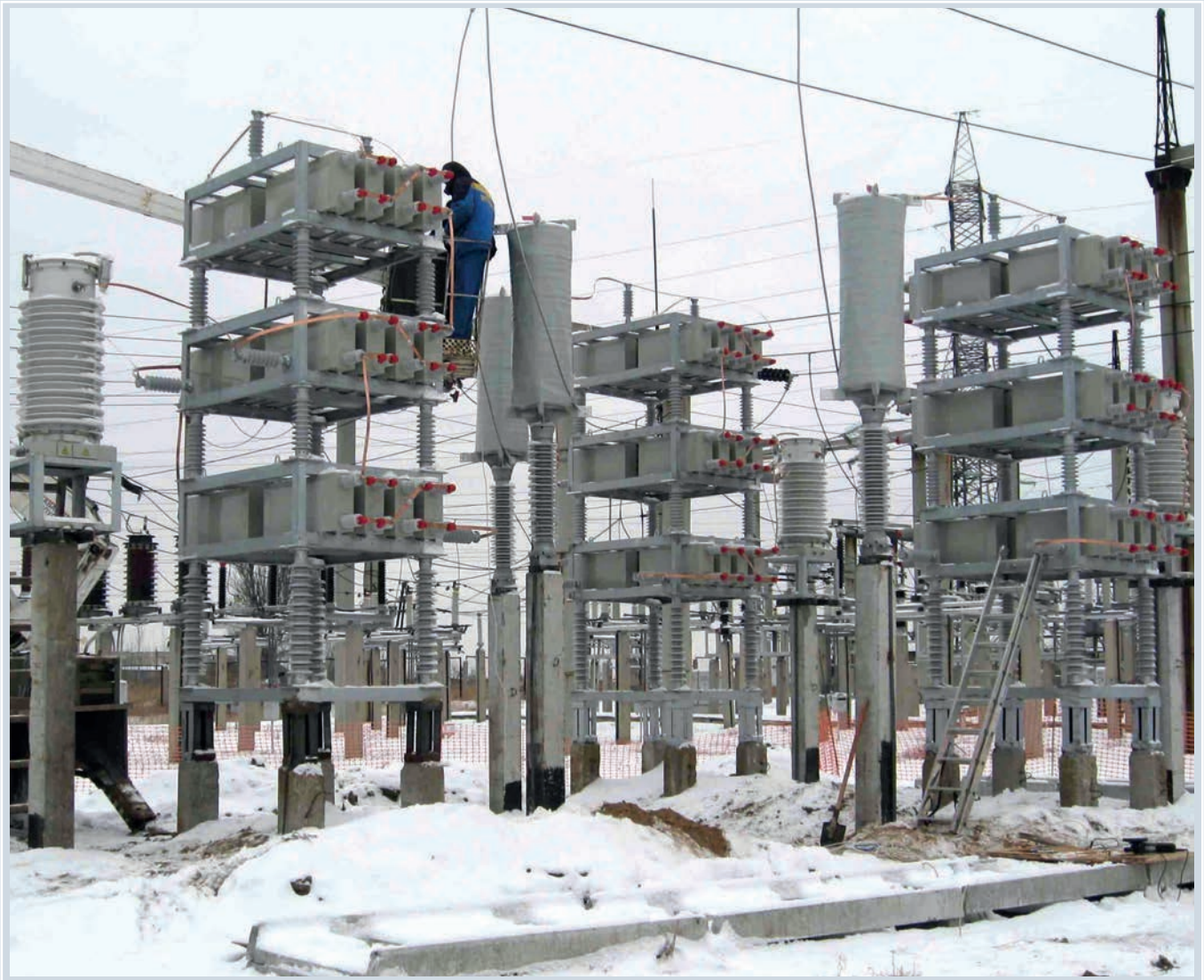
Батарея статических конденсаторов БСК-110 кВ-26 МВАр. В данный момент эксплуатируется на предприятии ОАО «Хабаровскэнерго», г. Хабаровск.
