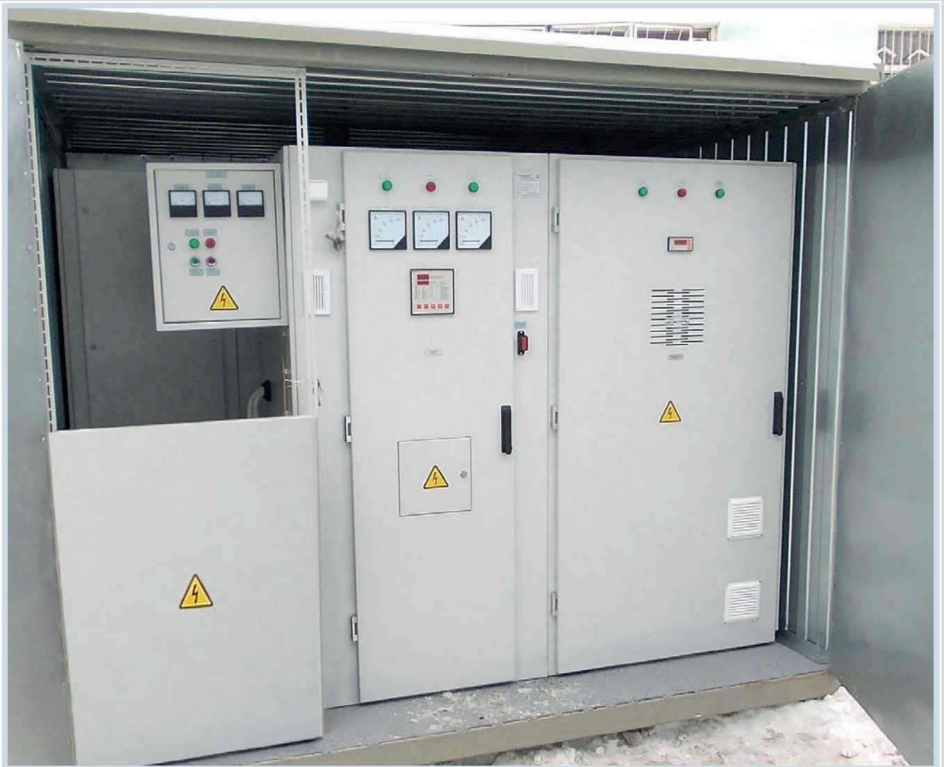
Конденсаторная установка УКРМ-10,5-1350-450 в малогабаритном контейнере. В данный момент эксплуатируется на предприятии ОАО «Новокузнецкий металлургический комбинат», г. Новокузнецк.
