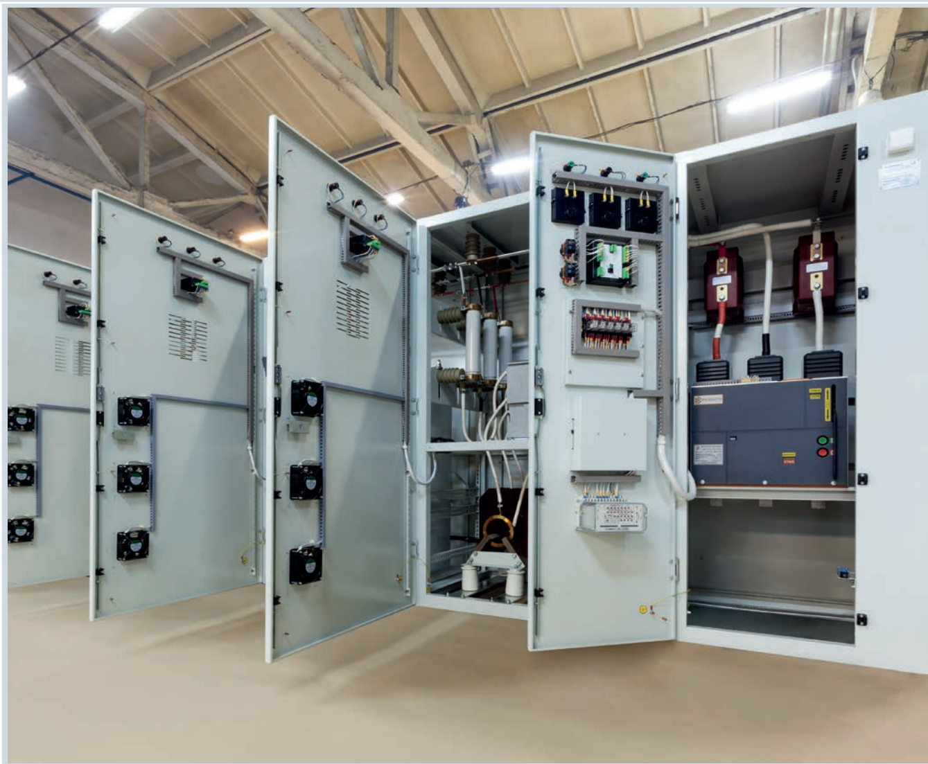
Конденсаторная установка УКРМ-6,3-3150-450 УХЛ 4.2.
