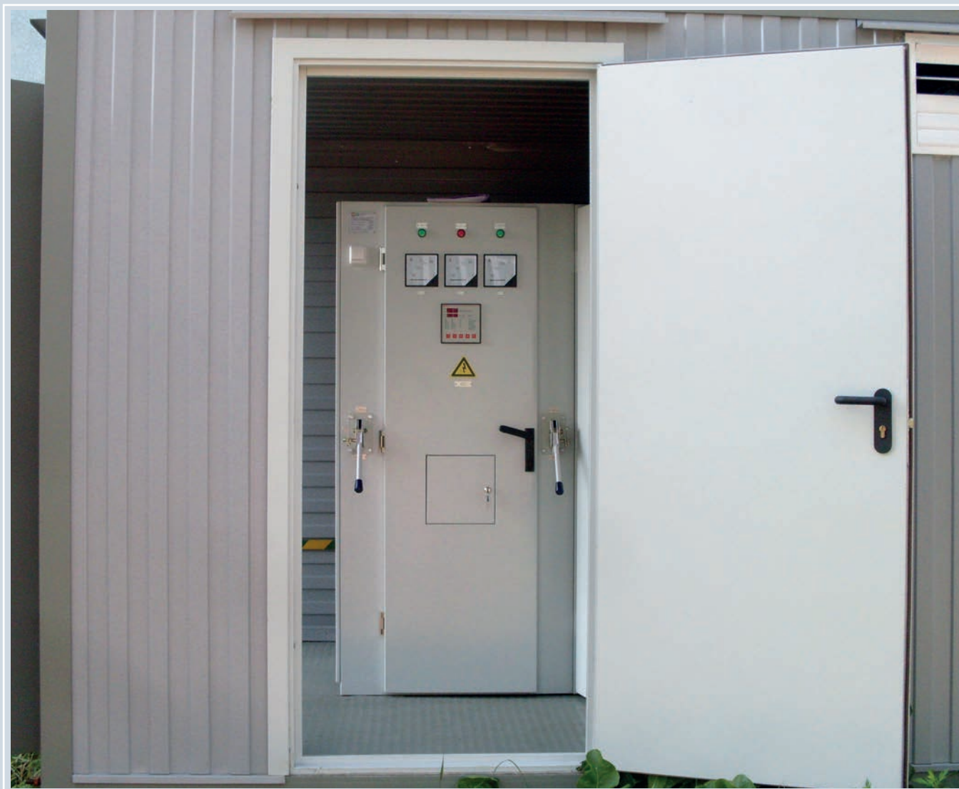
Конденсаторная установка УКРЛ56-6,3-600-200У3-К в утепленном северном контейнере исполнения ХЛ1. В данный момент эксплуатируется на предприятии ОАО НК «Роснефть» (месторождение «нефтепарк Колендо»), Сахалинская область.
